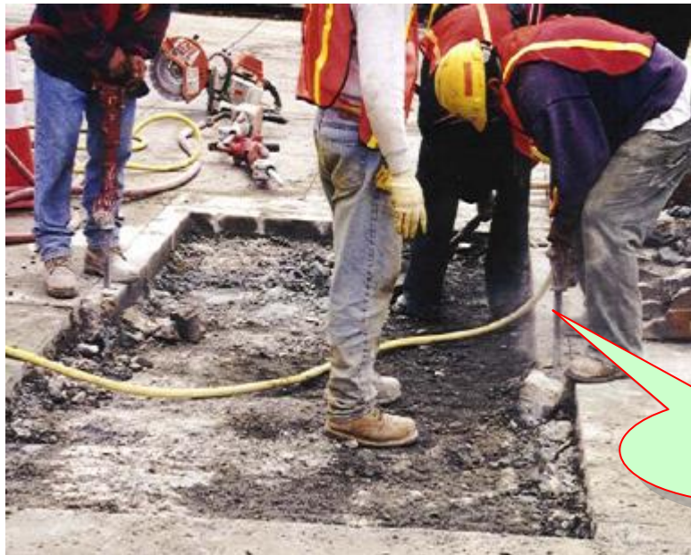
Demolición de losa a profundidad total
