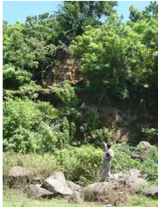
Foto No 1. Corte del Río Quezalaguaque y derrumbes de roca. Coordenadas UTM: 1382214/510362
