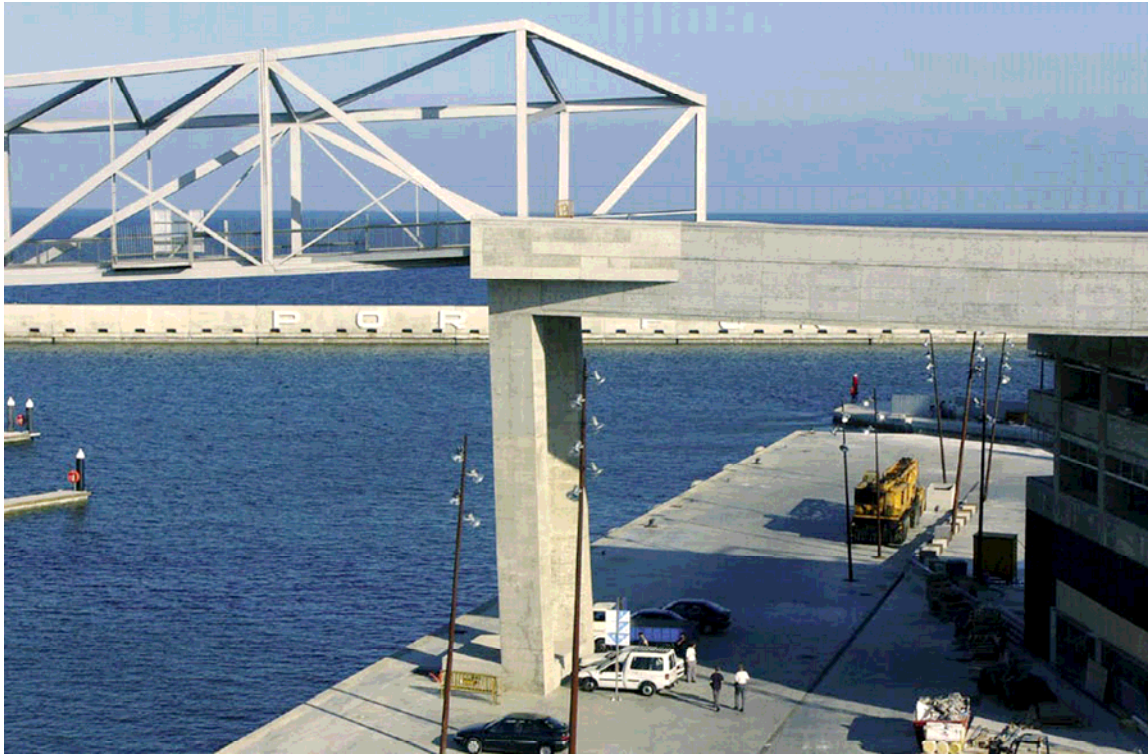
Pasarela en la zona del Forum de Barcelona cuyas bases de hormigón armado incorporan árido reciclado
