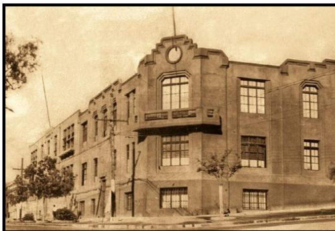
Consistorial de Tocopilla, edificación Arte Decó Americano construido en 1931.
