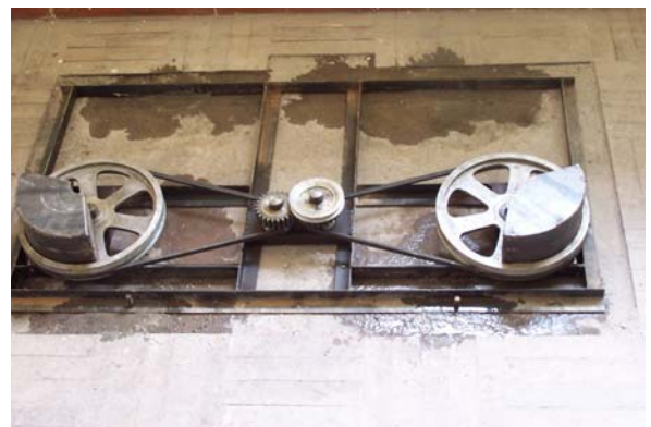
Fig. 8 Fotografía de la Instalación del Excitador
