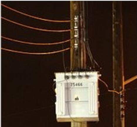
Aprovecha el fenómeno de inducción electromagnética para modificar el voltaje de una corriente eléctrica.
