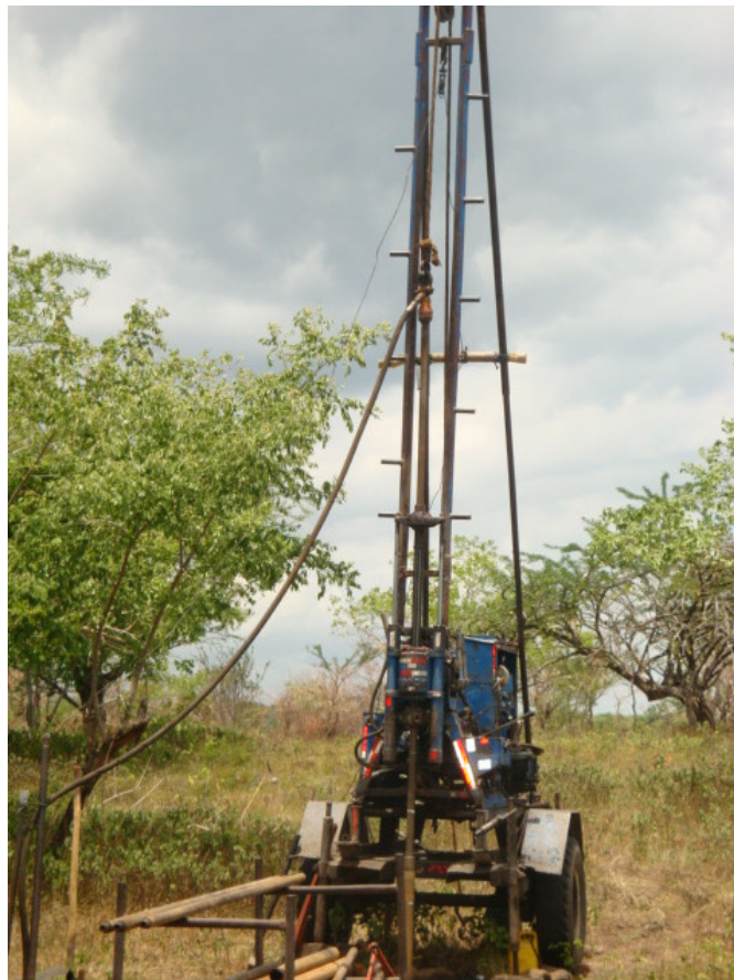
Foto No 1. Sondeo de rotación, equipo ligero sobre Neumáticos en Miramar (León, Nicaragua). (Foto T. Obando)
