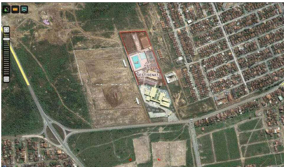
Figura 6 - Construção de Área recreativa no bairro das Malvinas
