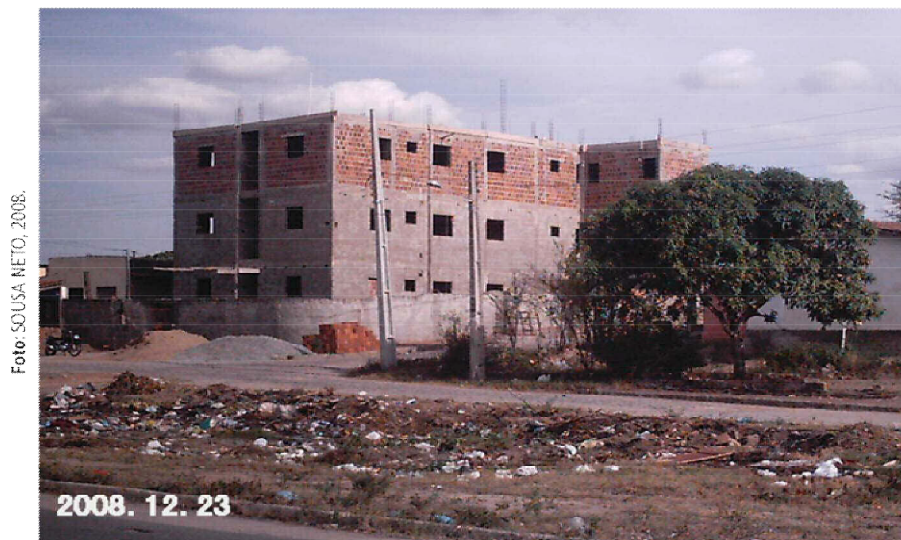
Foto1 - Edifício em processo de construção resultante expropriação Imobiliária no bairro das Malvinas
