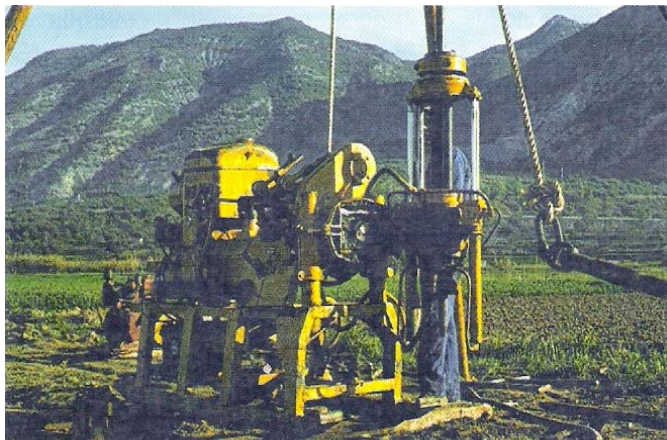
Sondeo en roca (SR)
