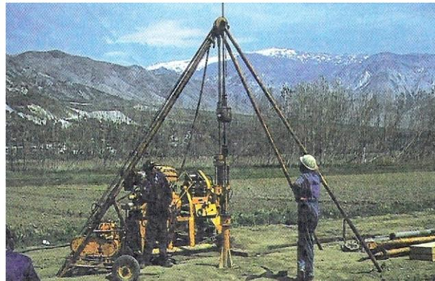
**Foto No 1.** EQUIPO DE PERFORACIÓN PARA SONDEOS GEOTÉCNICOS. Fuente: Vallejos (2002)
