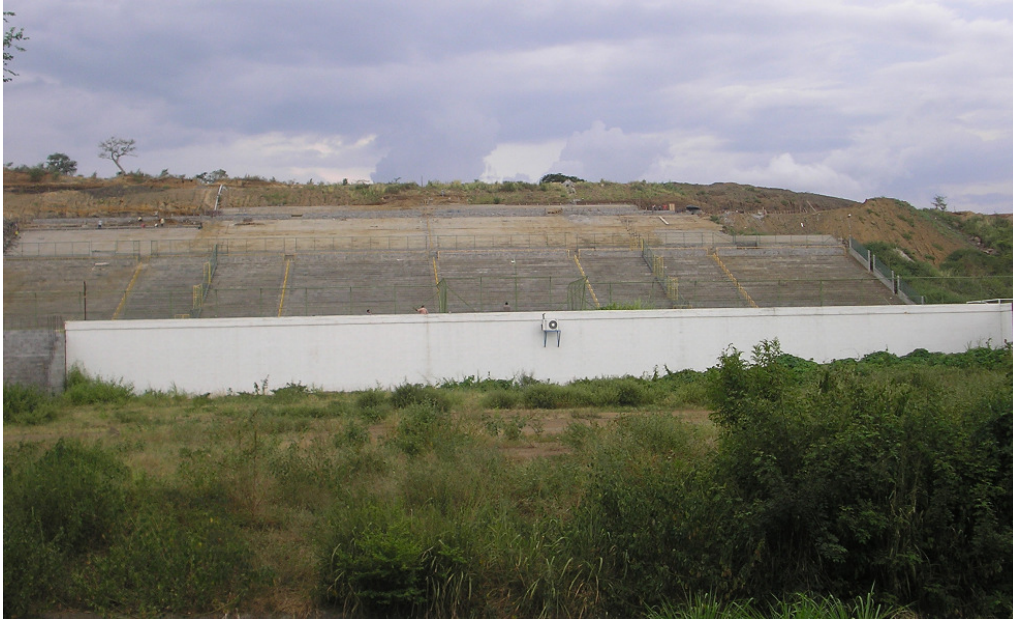
Foto No 1. Construcción de gradas de concreto en terrenos empinados e inestables para su uso por espectadores en Estadio de Football en un área al Sur de la Ciudad de Managua (Nicaragua). Foto de T. Obando, 2,009.
