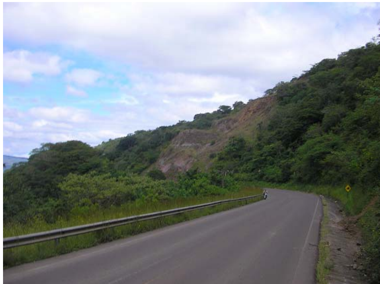
Carretera Managua –El Espino. Coordenadas UTMN1431089 – E5847907
