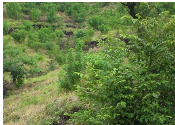
Foto No 14. Escarpe del terreno, indicativo de movimientos de laderas secundarias en Cerro de Reparto Fátima (Matagalpa). Foto T. Obando
