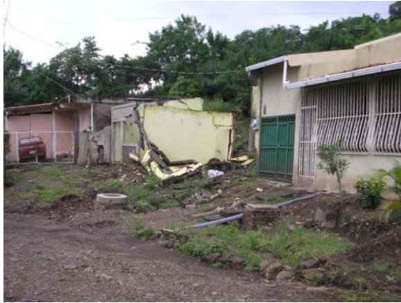
Foto No 15. Mostrando daños físicos a viviendas ubicadas al pie del deslizamiento del Cerro en Reparto Fátima (Matagalpa). Foto T. Obando
