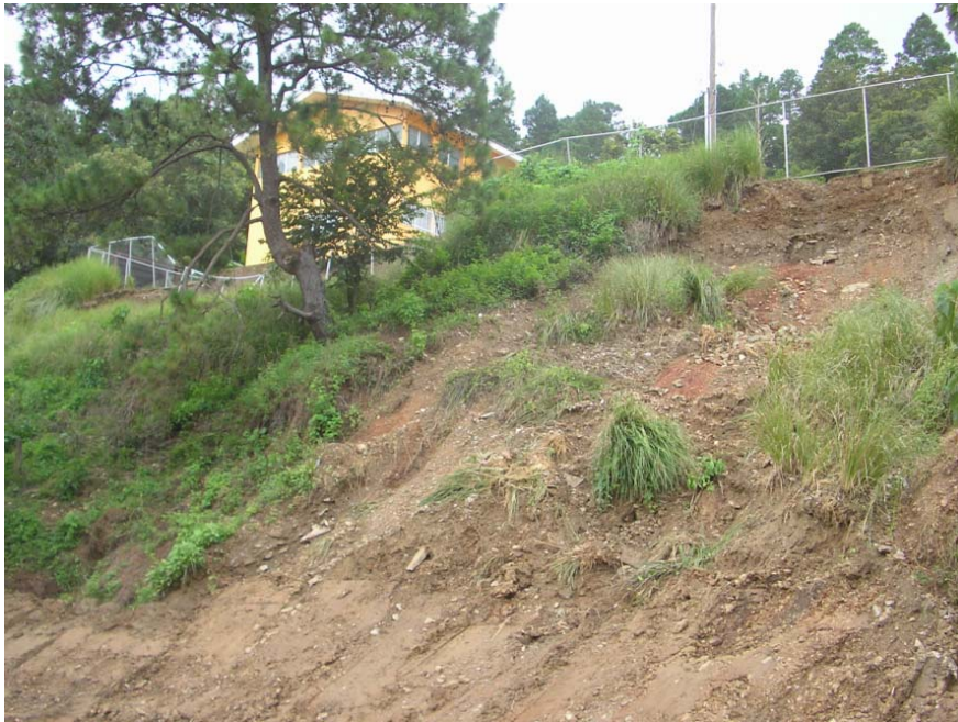
Vista de roturas curvas de movimientos de masas en sector exterior de Centro de Salud de Murra Municipio de Murra, Nueva Segovia
