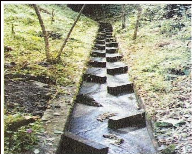
Canal con pantallas deflectoras.
