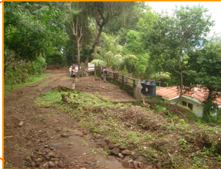
Propiedad afectada por flujo de las proximidades de laguna apoyo 2005.
