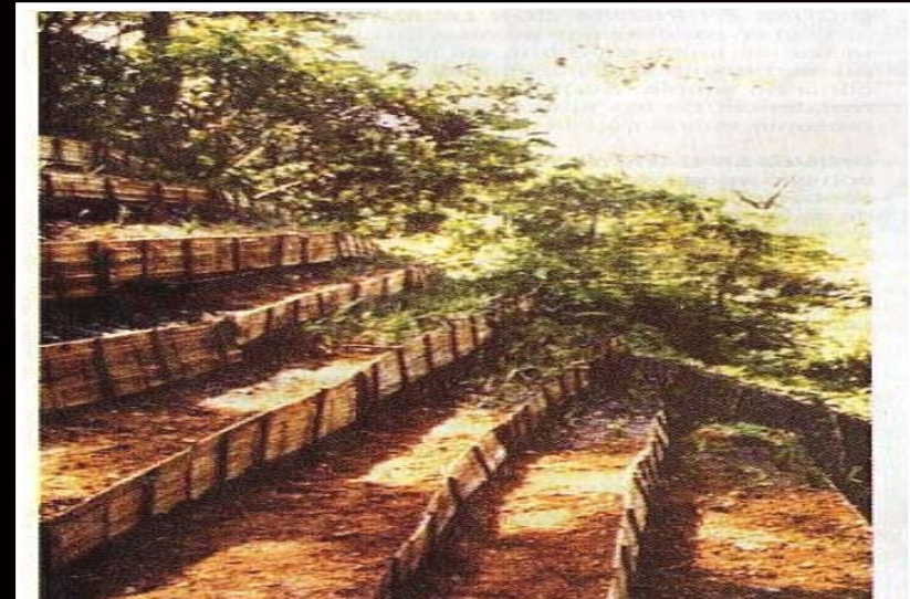
Trinchos en esterilla.
