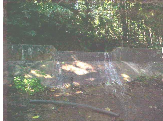
Foto 2 y 3. Dique toma “Centro de aducción” (caño Los Pijiguaos), para el suministro de agua al centro de mina y la estación de trituración.
