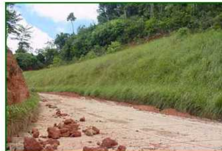
Foto 32 y 33. Tecnología Sistema Vetiver en recuperación de Taludes.
