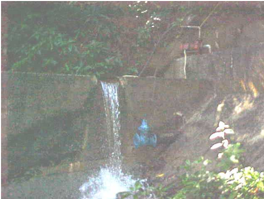
Foto 2 y 3. Dique toma “Centro de aducción” (caño Los Pijiguaos), para el suministro de agua al centro de mina y la estación de trituración.
