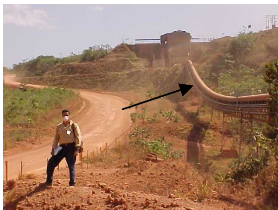
Foto 15 y 16. Correa transportadora del mineral de bauxita (correa de bajada).
