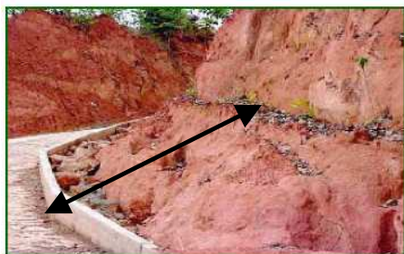
Foto 28 y 29. Tecnología Sistema Vetiver Interfaz Suelo-Concreto.
