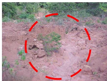
Foto 19. Grado de erosión en cárcavas (Chorro 1).
