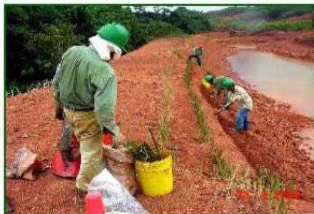
Foto 26 y 27. Siembra de Vetiver en Lagunas de sedimentación.
