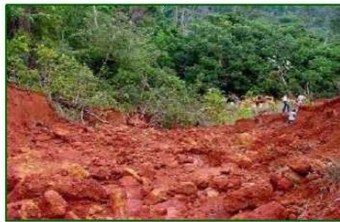
Foto 34. Tecnología Sistema Vetiver en recuperación de Taludes.
