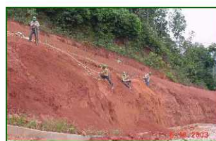
Foto 30 y 31. Tecnología Sistema Vetiver Talud “La Aducción”.
