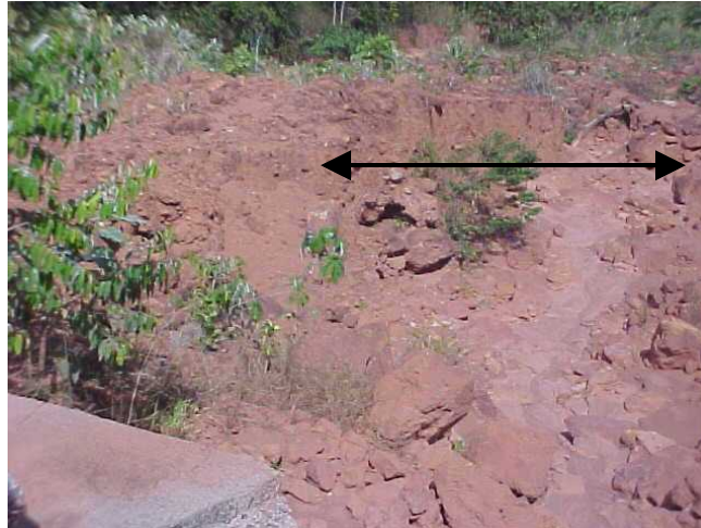
Foto 20. Socavación lateral “longitud en (m) de canal con socavación lateral: 64 m (Caño El Chorro).
