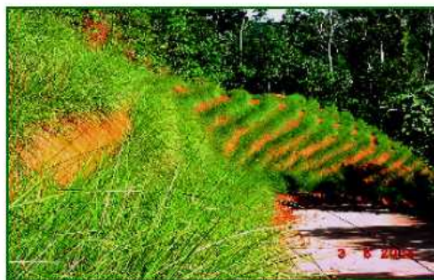
Foto 32 y 33. Tecnología Sistema Vetiver en recuperación de Taludes.
