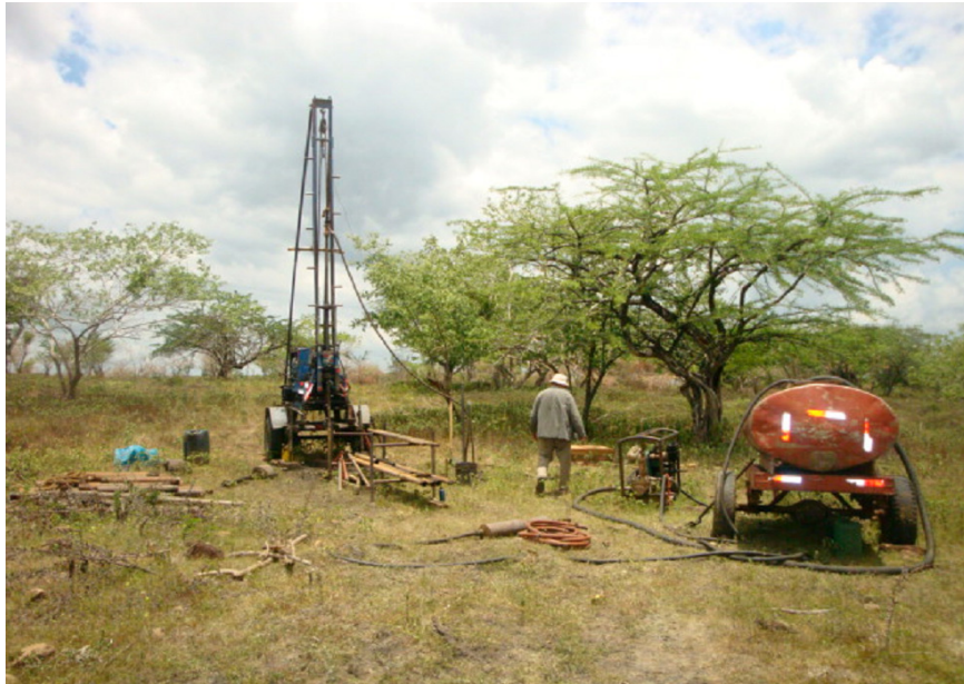
Foto No 1. Equipo de SPT en Miramar (León, Nicaragua)
