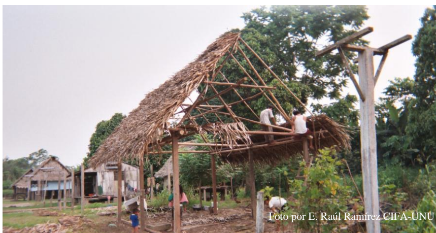
Foto 4: Construcción de una casa con partes de las palmeras. Pucallpa, Perú, 2005
