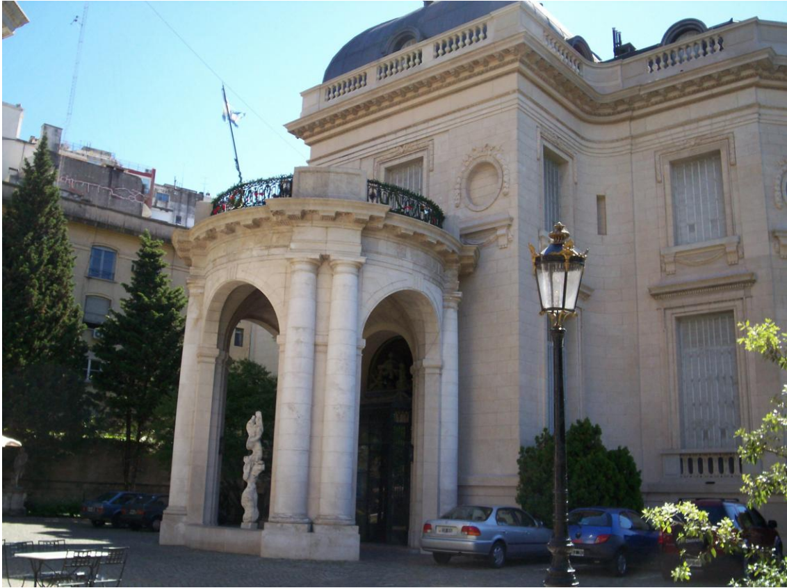
Imagen ( 382 ): Puerta de ingreso principal.
