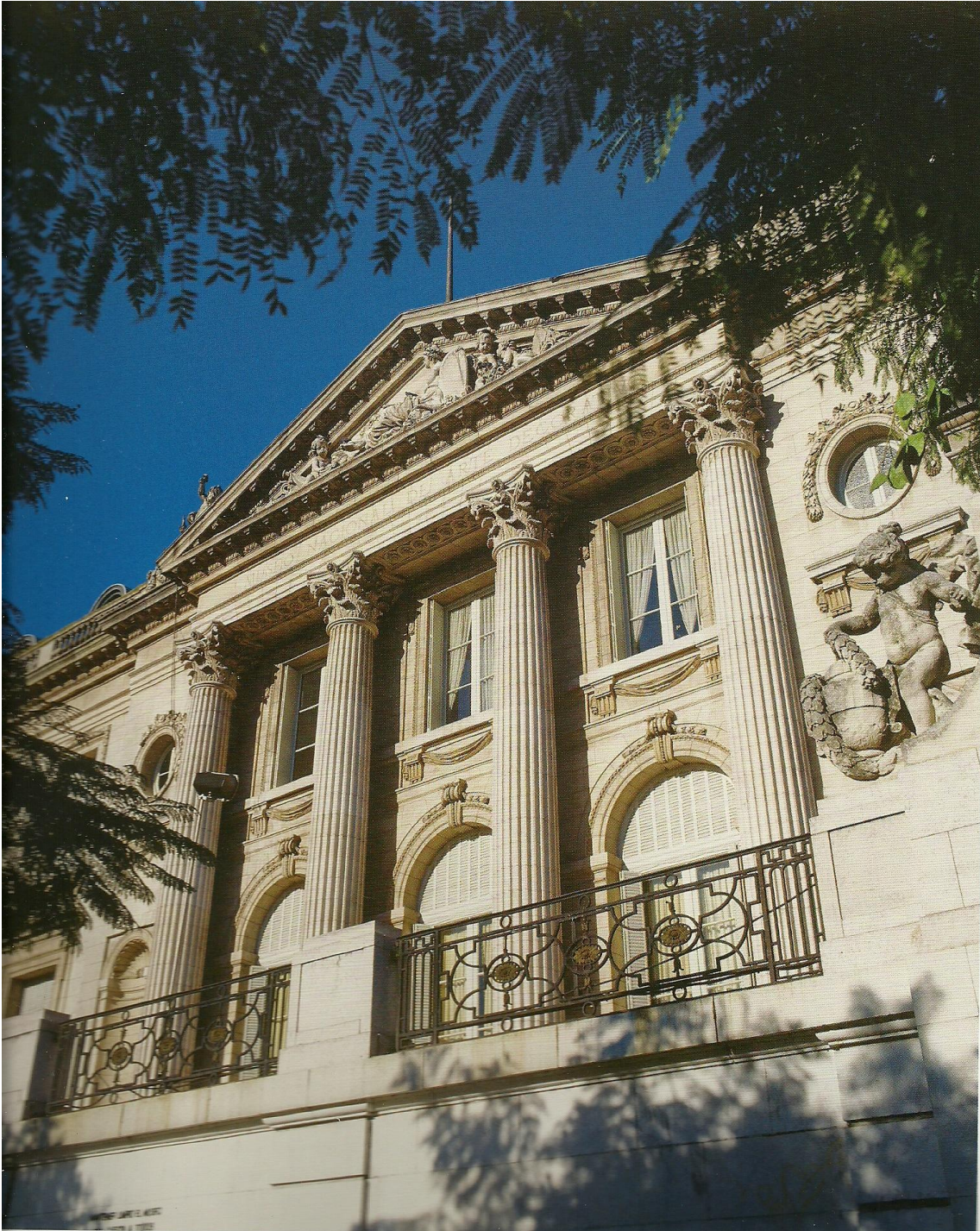
Imagen ( 375 ): Frente Avenida Libertador. Columnas de Orden Corintio, cuyo entablamento soporta el frontón (o frontis). Imitando el templo romano de Marte o el Panteón de Roma.
