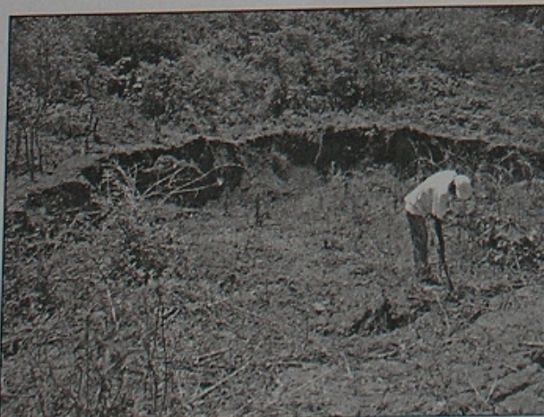
Fotografía 1: Escarpe principal de deslizamiento Cerro Juan Sapo
