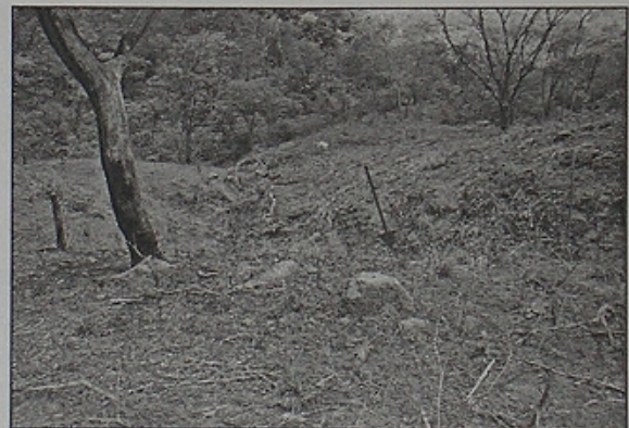
Fotografía 6: Borde Oeste del deslizamiento Cerro Juan Sapo, se muestra paredes de cárcava de 2 x 1.5 m en que circula agua superficial proveniente de la parte alta de la ladera del cerro.
