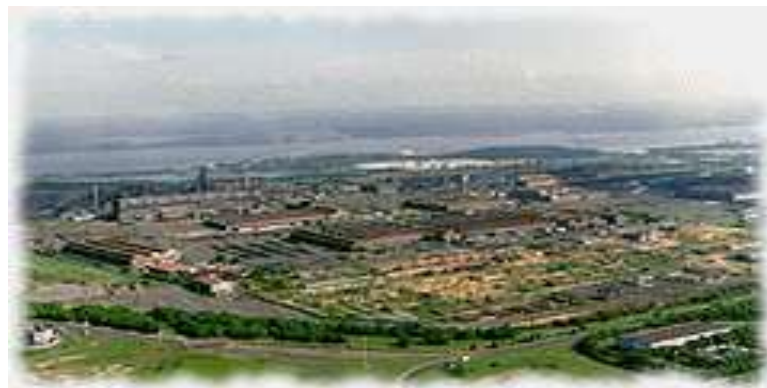
Figura 2.3: Planta SIDOR C.A (Fuente: Intranet de SIDOR 2008)
