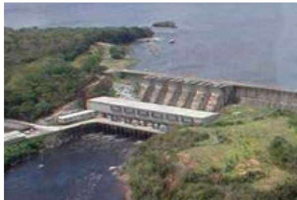
Figura 1 – Casa de Máquinas I – Macagua
