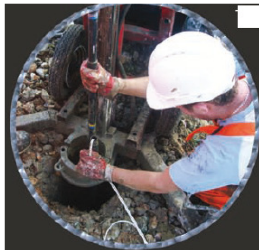
Foto No 6. Instalación de un Magnetic
