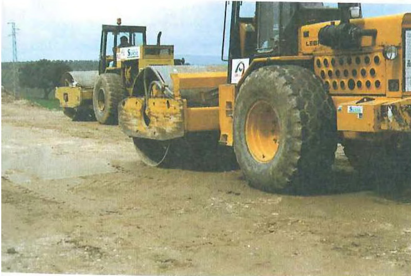
Compactación de la coronación de un terraplén con rodillo liso vibratorio.
