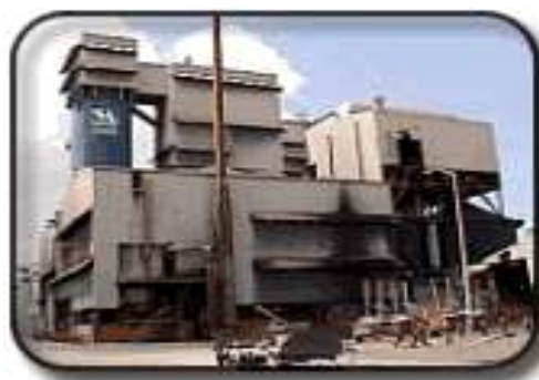
Figura 2. Vista de la Planta de Carbón Fuente: Manual Intranet CVG VENALUM
