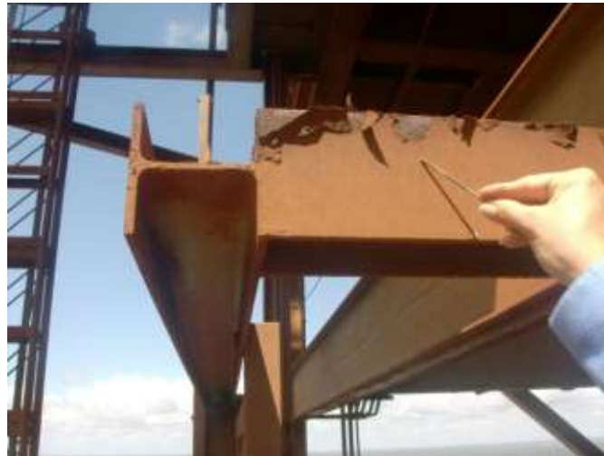
Figura N° 9: Inspección visual realizada.
