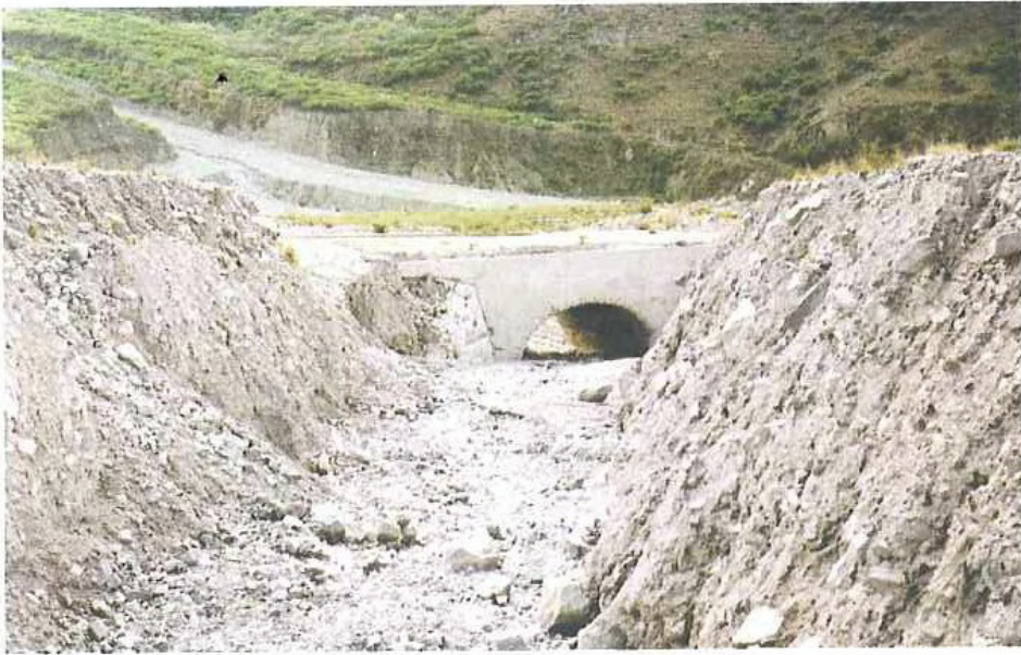
Colmatación de cauce que rebasa la carretera y obliga a abrir un cauce artificial, Quebrada de Purmamarca, Argentina (foto M. Ferrer)
