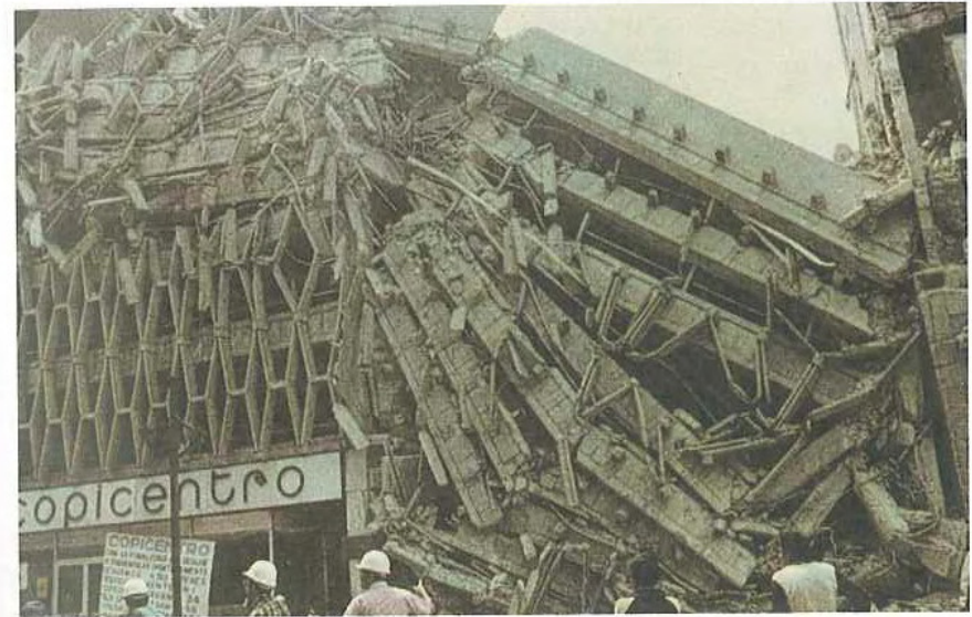
Edificio destruido en el terremoto de México de 1985 (cortesía del IGME)
