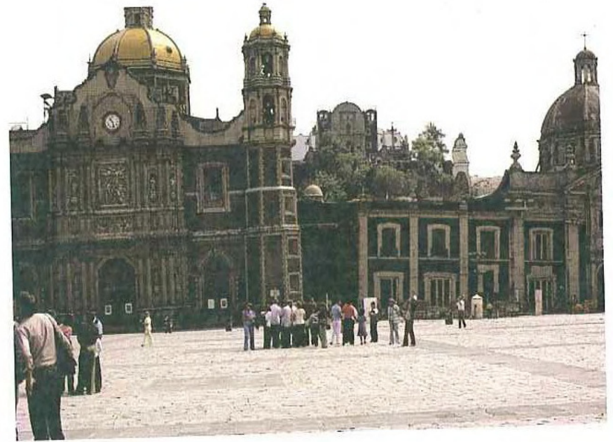
Subsidencia en suelos lacustres afectando a la Basílica de N. a S. a de Guadalupe (México D.F.)
