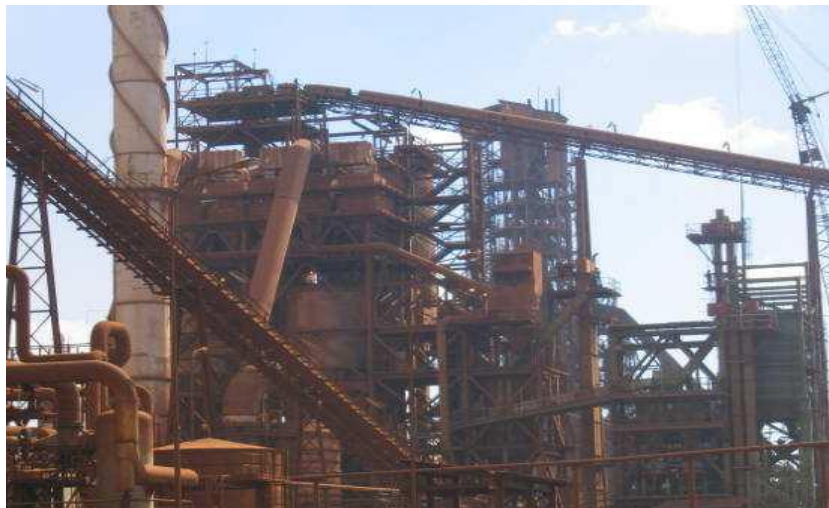
Figura 3. Área de preparación de mineral y producto.
