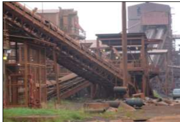
Cinta transportadora de materiales de Patio de Consumo
