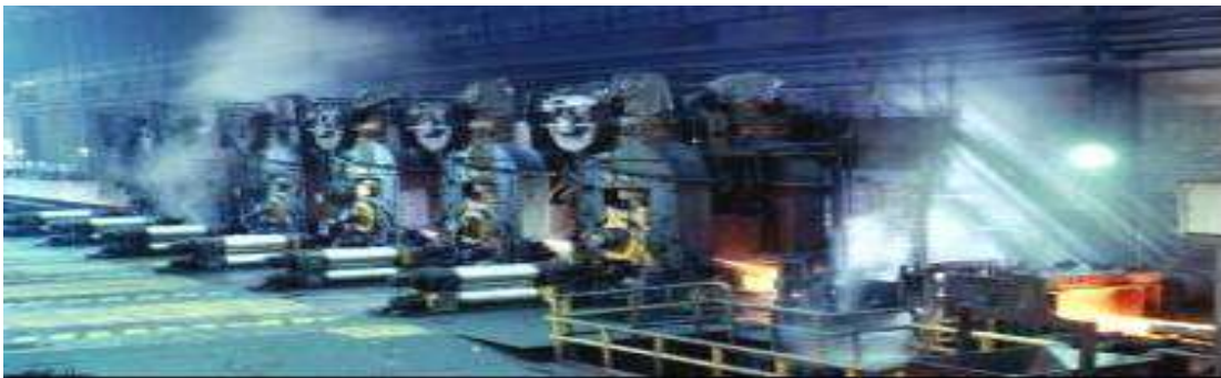
Figura 6: Imagen que muestra el Laminador semi continuo en caliente. Fuente: INTRANET SIDOR.
