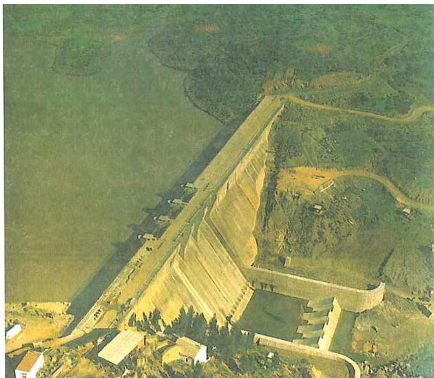
Presa de Sancho (Huelva), de gravedad, de 50 m de altura (cortesía del CNEGP).
