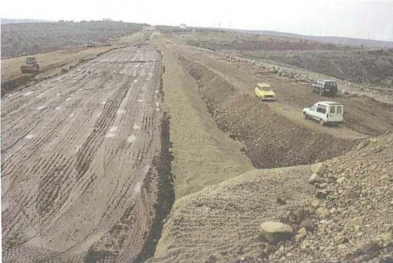
Materiales del núcleo, a la izquierda, y de drenes, en primer plano (foto L. González de Vallejo).
