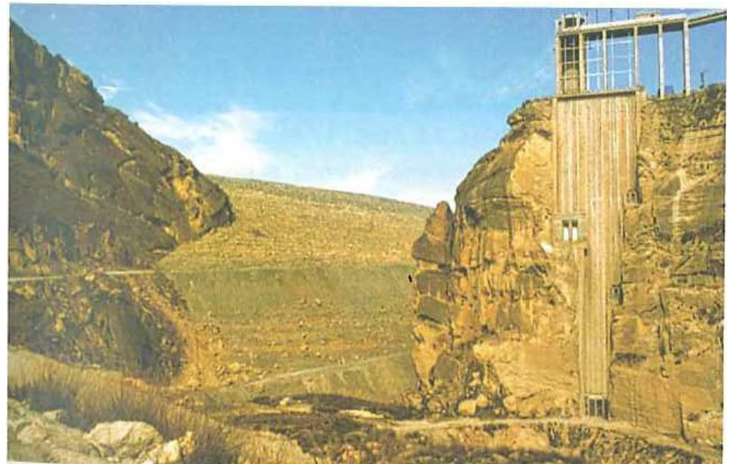
Presa de Canales (Granada) vista desde aguas arriba, sobre areniscas y margas limosas; presa de materiales sueltos de 156 m de altura, con espaldones de escollera y núcleo central de arcillas; obsérvese la torre de toma
