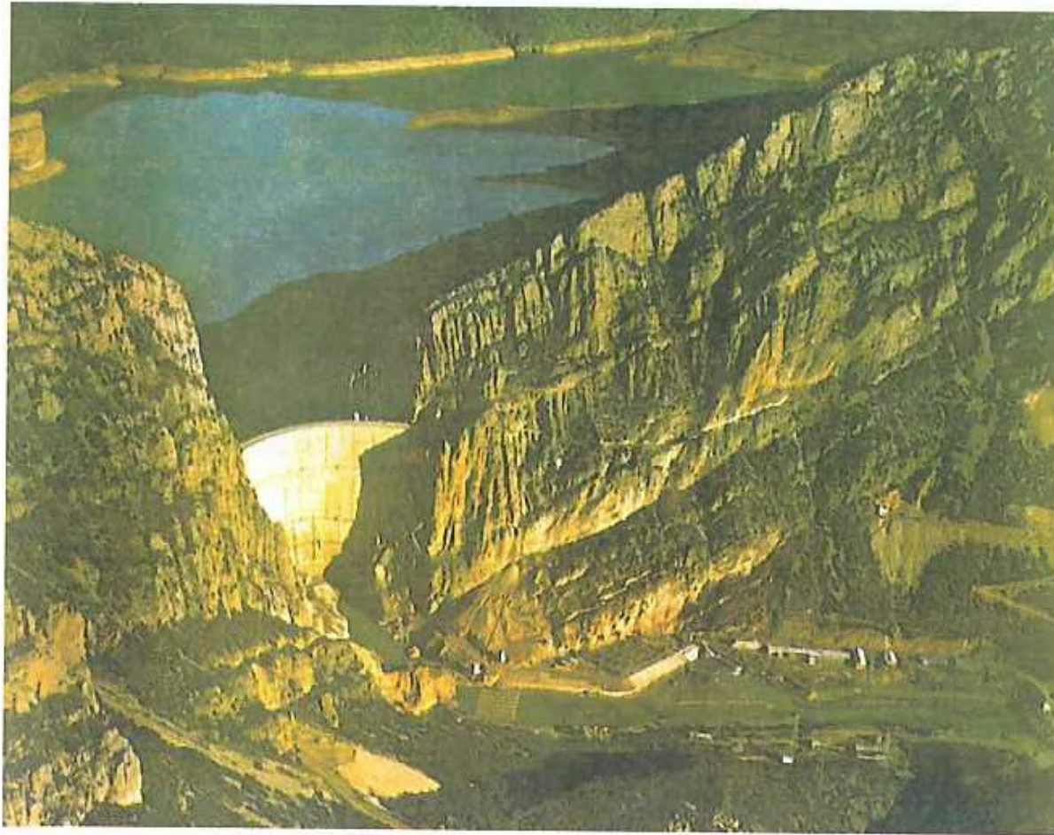
Presa de Canelles (Pirineo de Lérida) sobre calizas del Cretácico; presa bóveda de 151 m de altura (cortesía del CNEGP).
