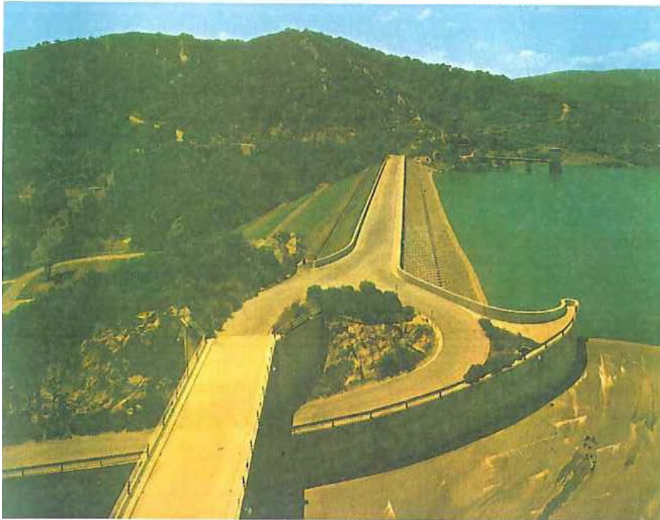
Presa de Guadarranque (Cádiz) sobre areniscas y margas del Eoceno; presa de tierras con núcleo de arcilla de 71 m de altura; en primer plano el aliviadero y al fondo la torre de toma
