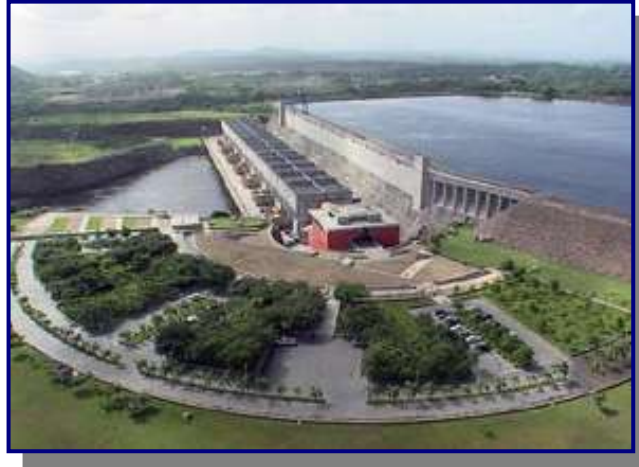
Figura 1.2. Complejo Hidroeléctrico Macagua II.
