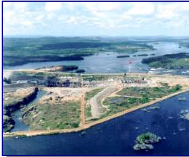
Figura 1.4. Central Hidroeléctrica Tocomá (en construcción)
