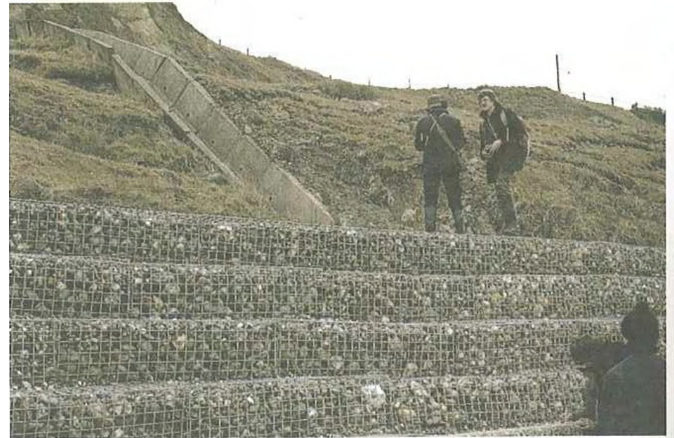
Muro de gaviones a pie de talud y cuneta de drenaje (foto L. González de Vallejo).
