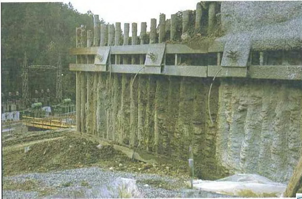
Pantalla anclada de micropilotes, norte de Italia to L. González de Vallejo).
