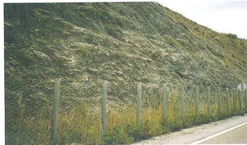
Protección superficial de taludes con mallas metálicas. A pie de talud se ha instalado una barrera para evitar la caída de rocas a la carretera (foto M. Ferrer).
