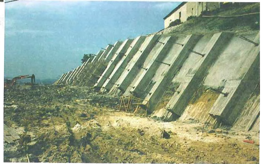
Instalación de anclajes para reforzar el talud, uni- dos mediante vigas de hormigón armado para que trabajen de forma solidaria, Asturias (foto L. Gon- zález de Vallejo).
