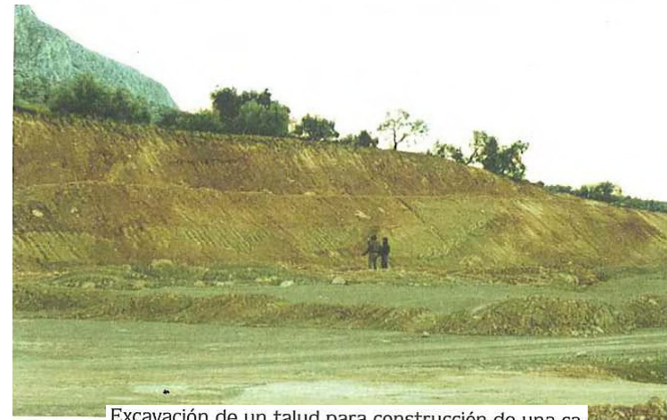
Excavación de un talud para construcción de una carretera (foto M. Ferrer).
