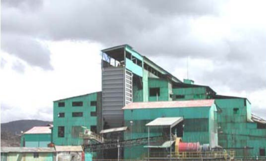
Fotografía N° 13: Planta Concentradora Paragsha que incrementara su capacidad de 8500 TMPD a 9500 TMPD.
