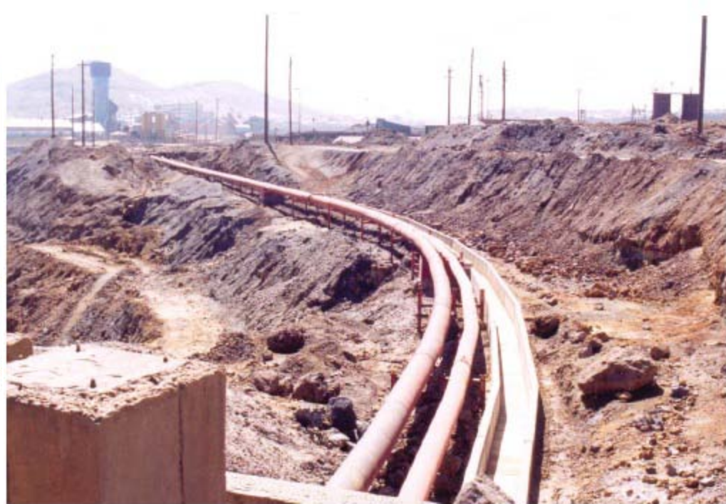
Fotografía N° 10: Tuberías de 14" de diámetro, que conducen los lodos provenientes de la planta de beneficio a la presa de relaves de Ocroyoc, actúan alternativamente la una como contingente de la otra, ambas con un canal de concreto de contingencia de ambas.
