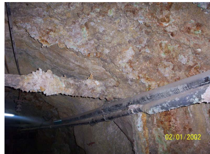
Fotografía N° 10: Tuberías de 14" de diámetro, que conducen los lodos provenientes de la planta de beneficio a la presa de relaves de Ocroyoc, actúan alternativamente la una como contingente de la otra, ambas con un canal de concreto de contingencia de ambas.
