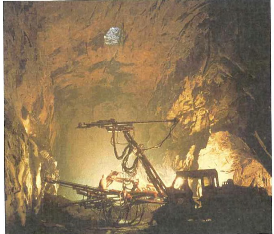
Excavación de una central hidroeléctrica subterránea (cortesía de J. Granero).
