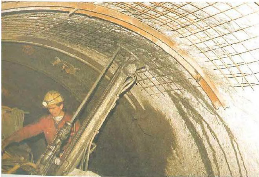
Instalación de bulones friccionales tipo «Swellex», con cerchas, mallazo y gunita (cortesía de M.
