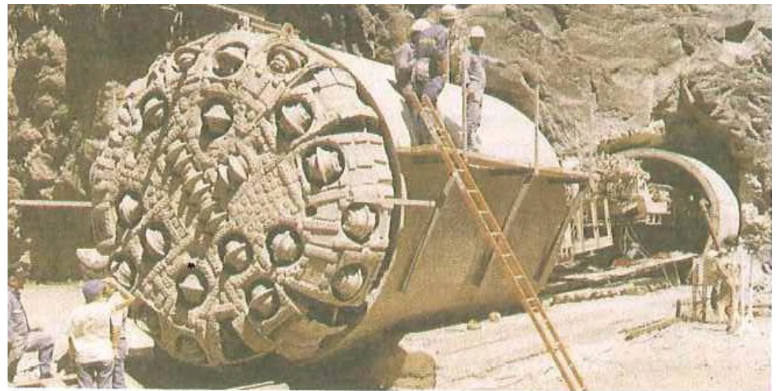
Tuneladora TBM «Robbins» para rocas
