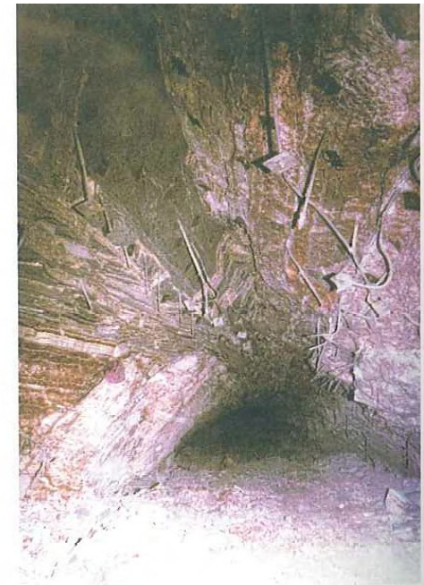
Grandes deformaciones en lutitas y sales: a) inicio de roturas en el techo; b) roturas generalizadas con grandes empujes en hastiales; c) cierre casi completo de la excavación con rotura de bulones (fotos L. González de Vallejo).
