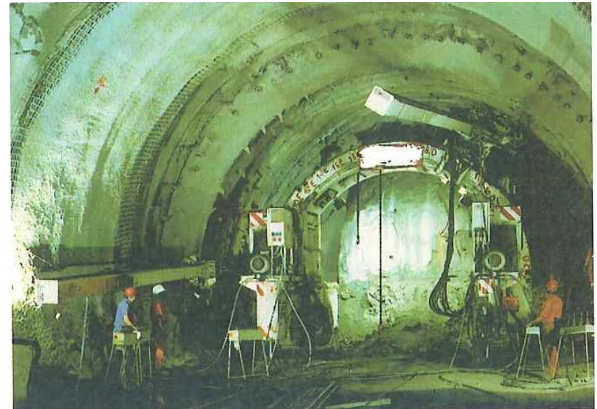
Excavación mediante precorte mecánico
