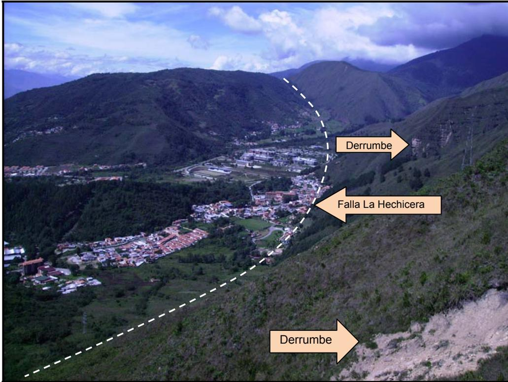
Figura 9. Falla la Hechicera y derrumbes de rocas correspondientes a la formación Mucujún
