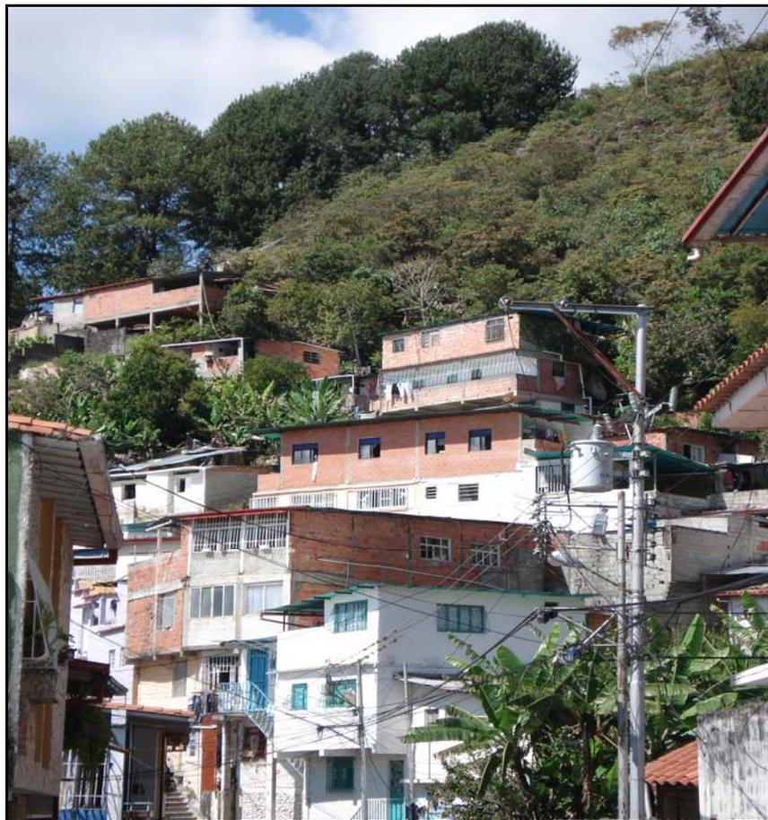
Figura 24. Viviendas de alta vulnerabilidad debido a una alta densidad constructiva, ubicadas en el pie y borde del talud
