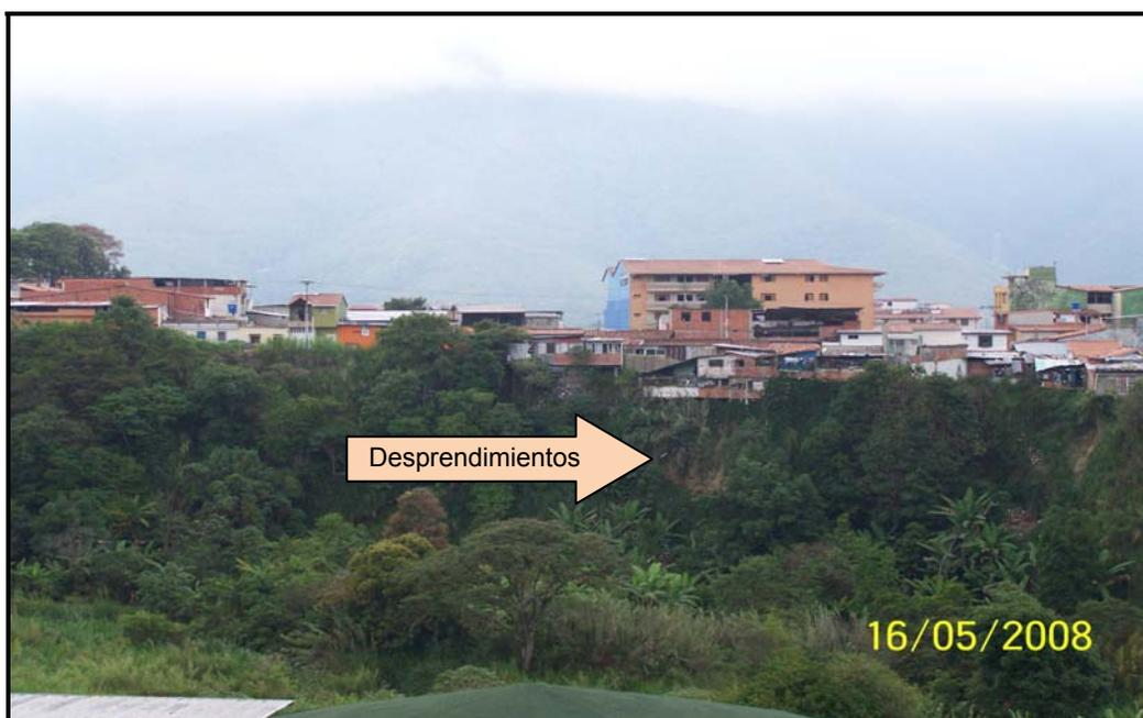
Figura 12. Derrumbe de detritos por socavación lateral de la quebrada Milla
